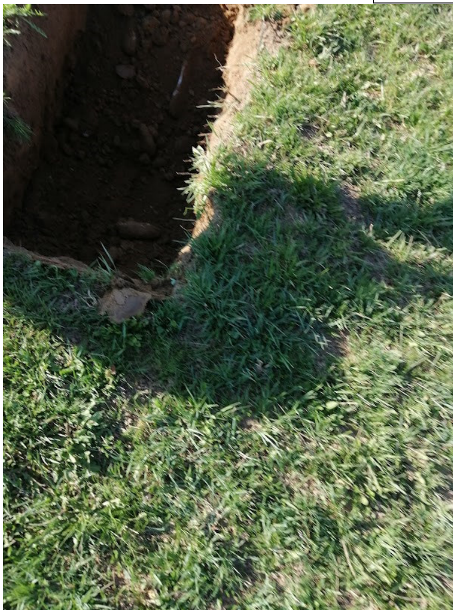
FOTO 2 – Aspetto scavo esplorativo P3
