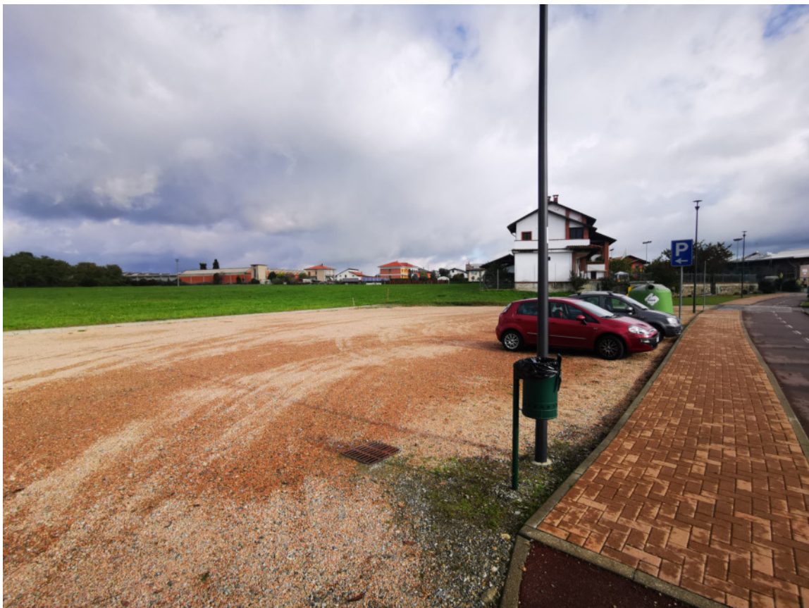
Vista su parcheggio esistente oggetto di sistemazione
