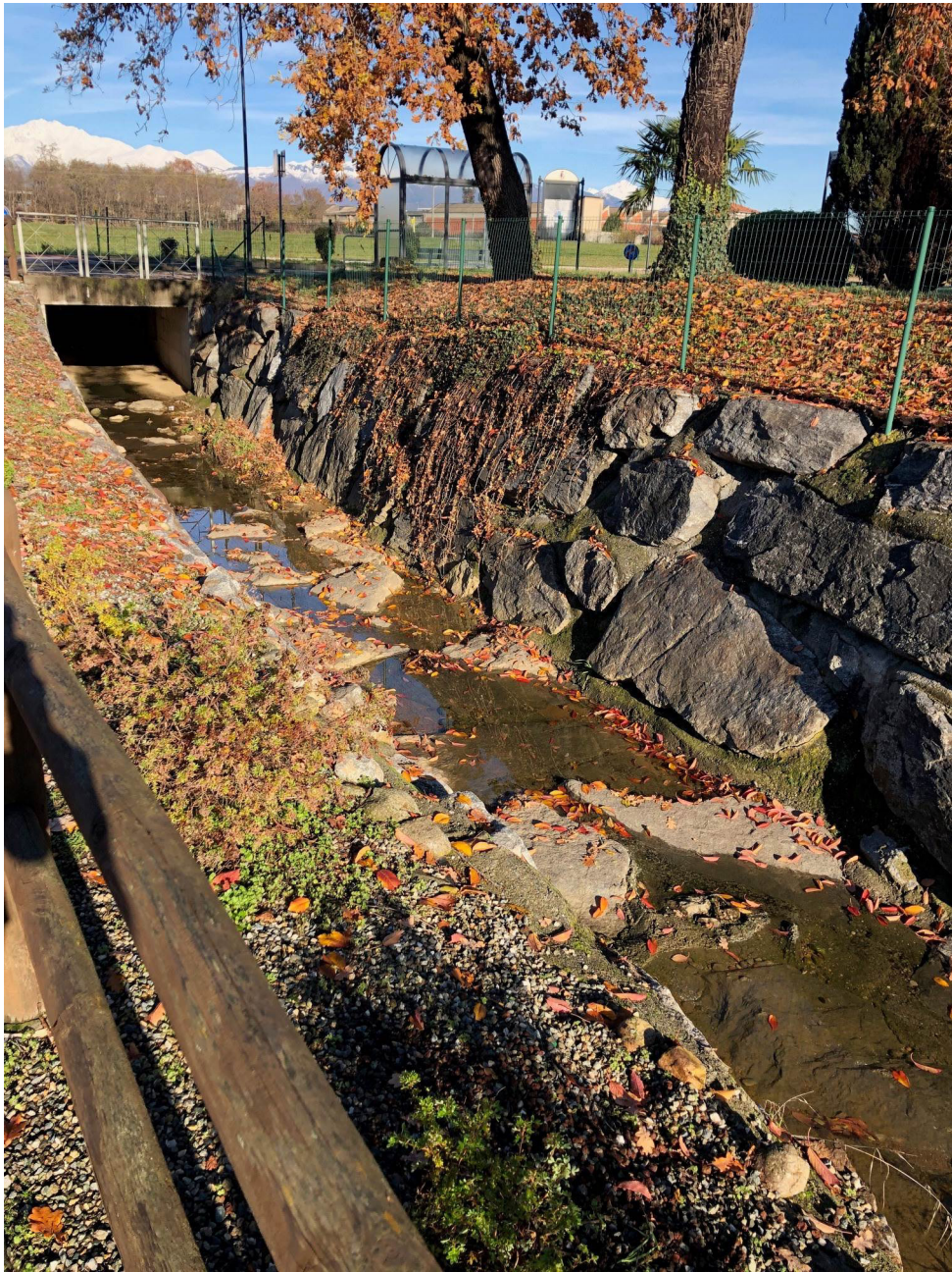
Foto 5 – panoramica alveo presso sbocco tombinatura
