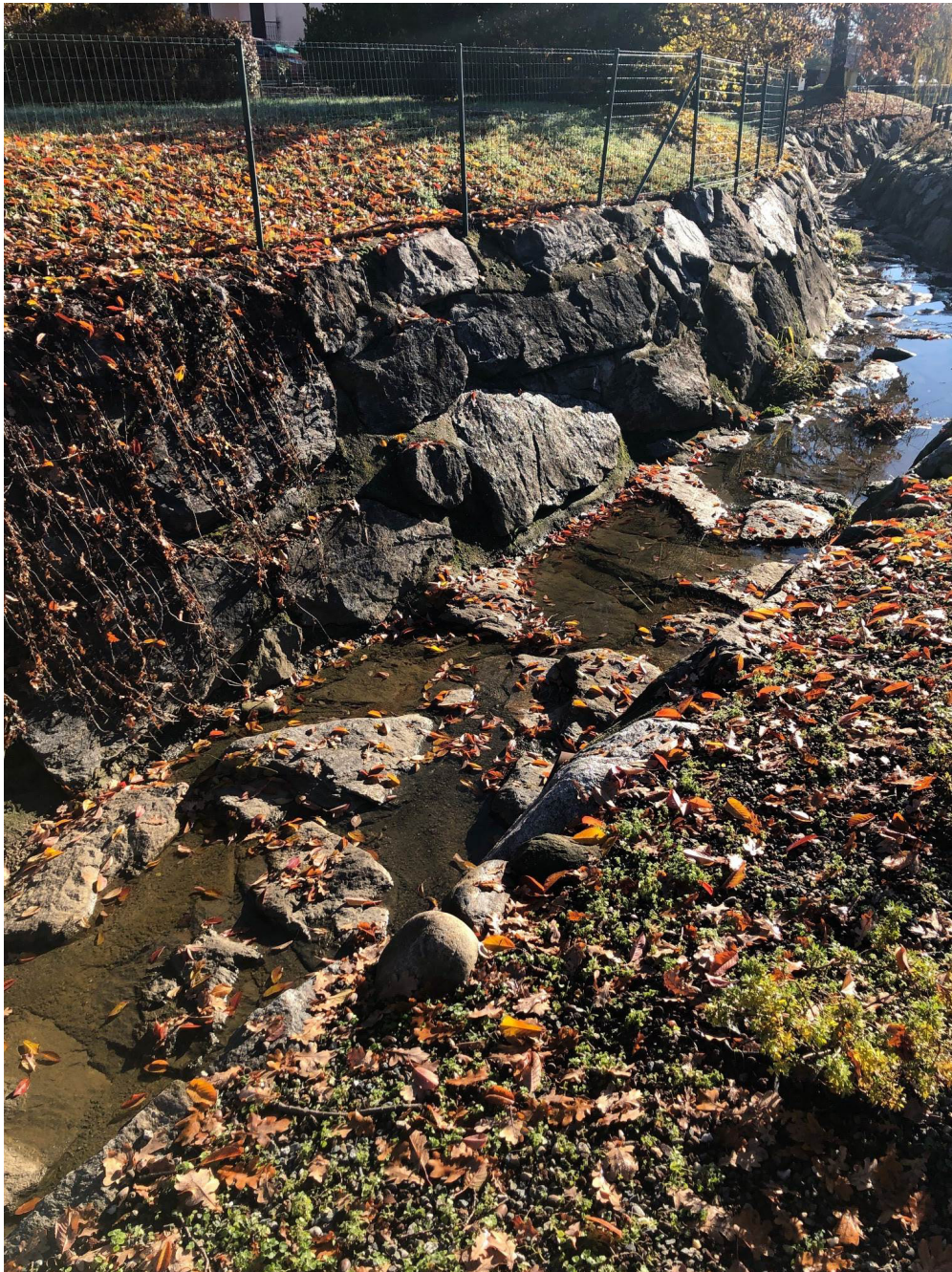
Foto 7 – alveo verso valle a 30 m da sbocco tombinatura
