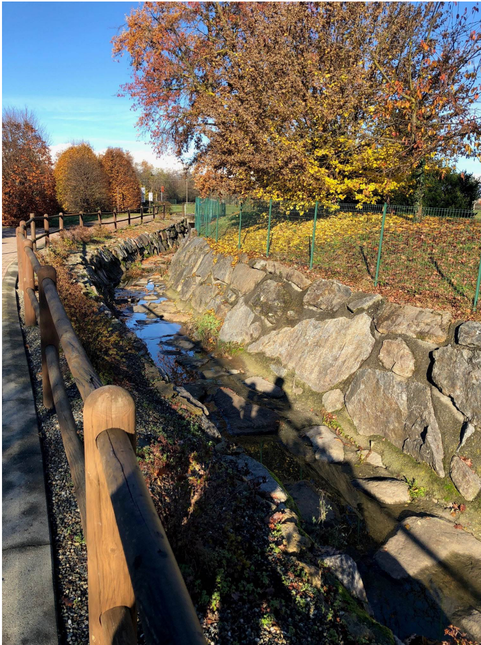
Foto 8 – alveo verso monte a 40 m da sbocco tombinatura
