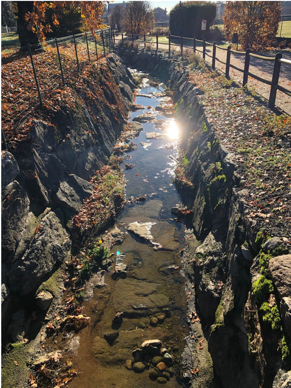
Foto 6 – panoramica alveo verso valle a 20 m da sbocco tombinatura
