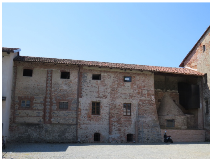
FOTO 2: Vista prospetto nord
