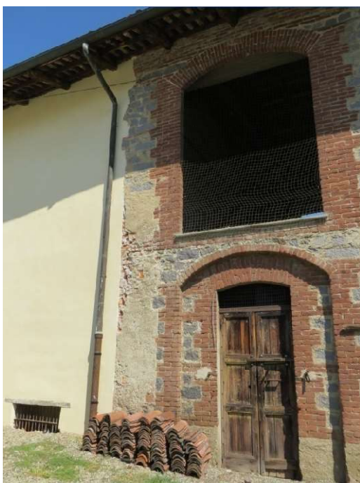
FOTO 3: Porzione facciata a sud
