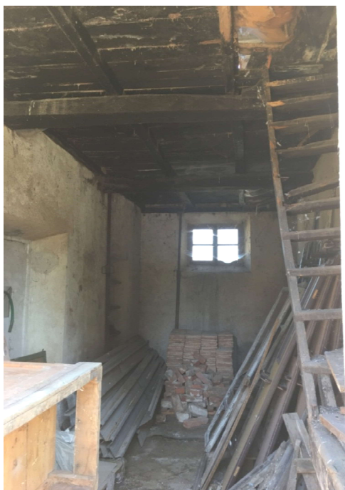
FOTO 11: Locale destro piano terreno con solaio in legno
