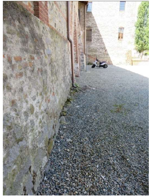
FOTO 6: Scarichi cortile nord
