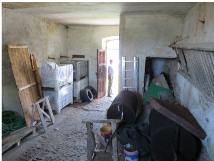
FOTO 15: Locale sinistro piano terreno con solaio in voltini
