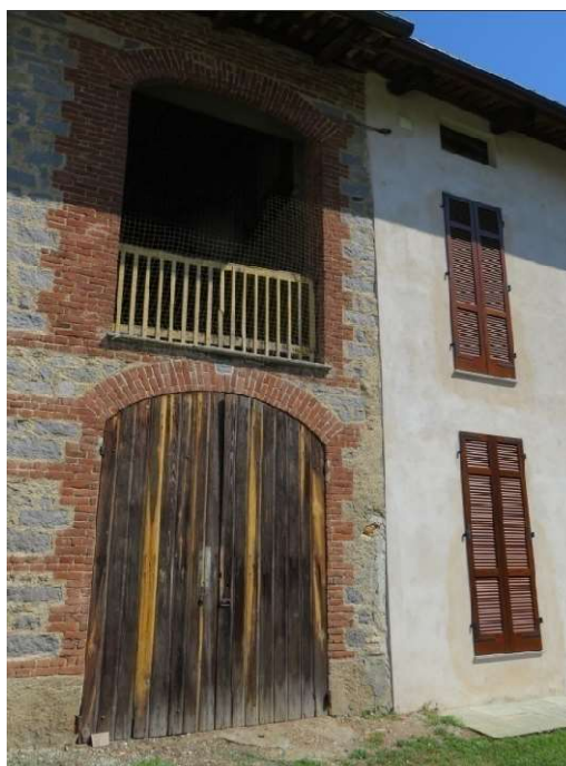
FOTO 4: Porzione facciata a sud
