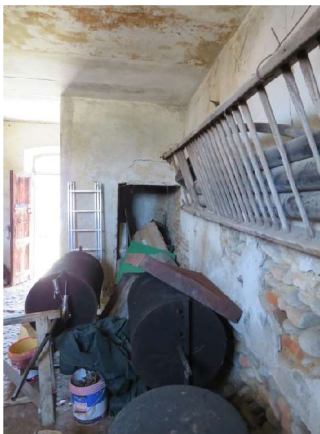
FOTO 18 : Locale sinistro piano terreno tramezzi da demolire
