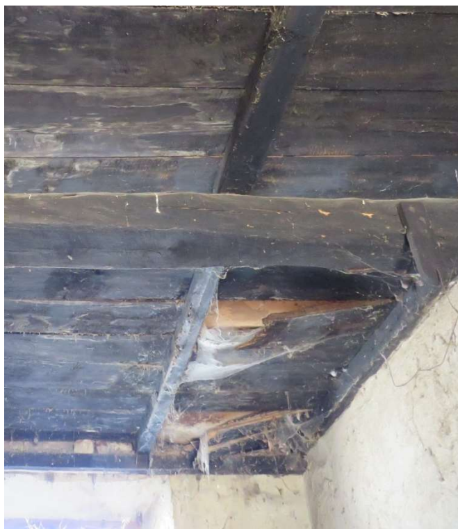
FOTO 14: Locale destro piano terreno particolare sfondamento assito
